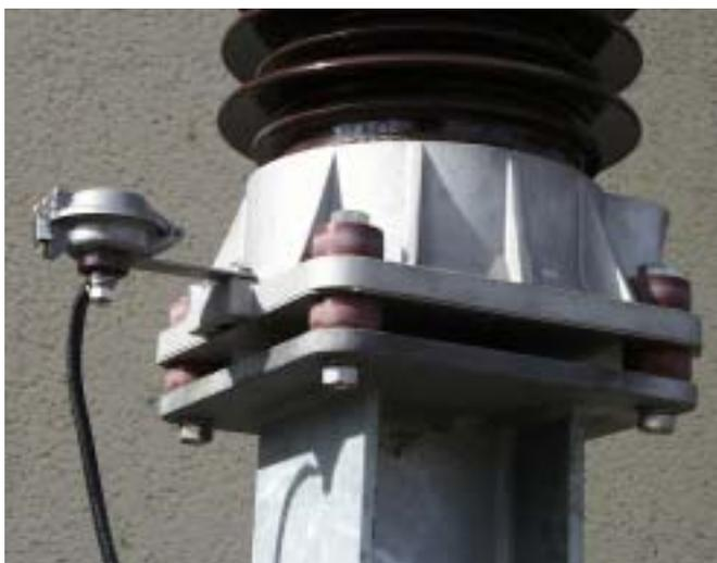
Fig. 13: Brida inferior con la base aislante y el explosor de supervisión (klidonógrafo)
